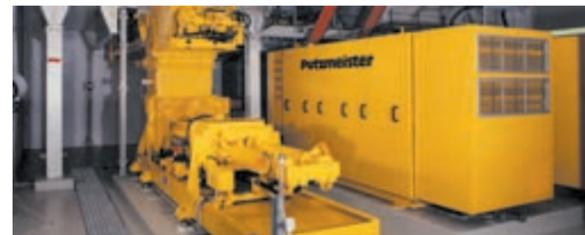
Co-incenerimento di fanghi di depurazione in una centrale elettrica a carbone presso Zolling (Germania): pompa serie KOS 2180
